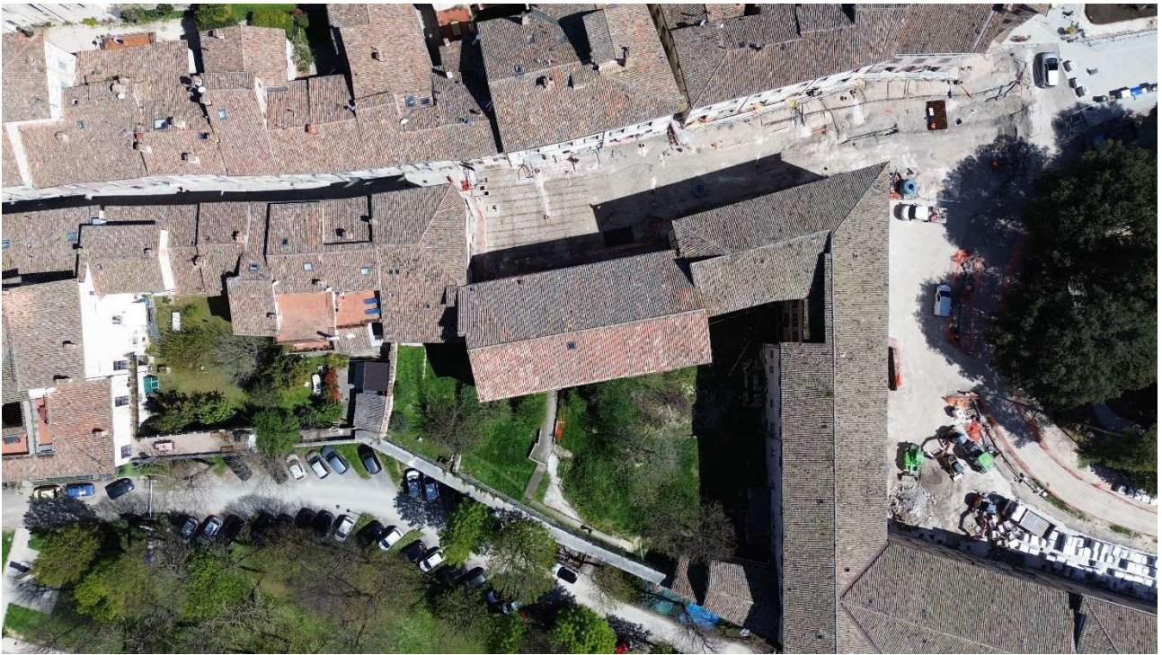
17 – Veduta con drone dell'area ex INAM
